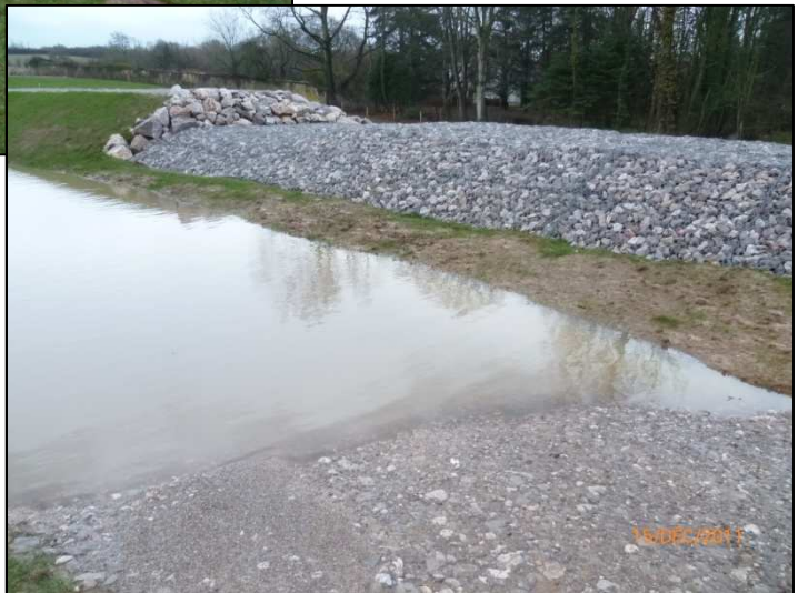
Bassin de l'Hermitte – le 15 décembre 2011 vers 9h. Il reste près d'1m avant la surverse
