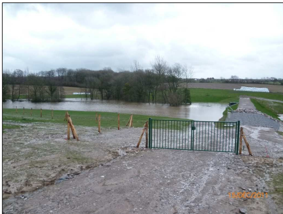
Etendue de la zone inondée par l'ouvrage, vue de l'entrée du site – 15 décembre 2011 vers 9h
