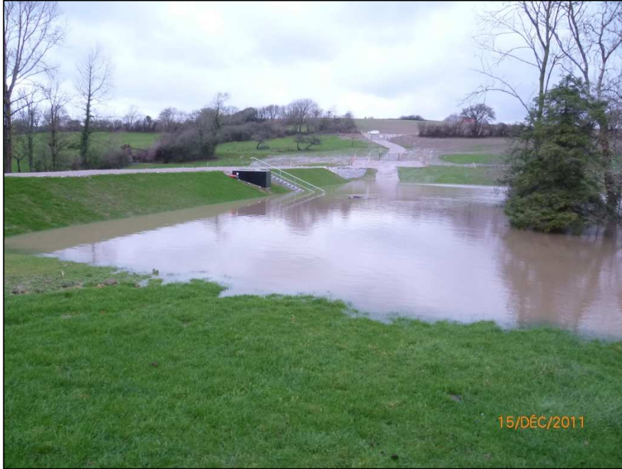
Bassin de l'Hermitte rempli par la crue – le 15 décembre 2011 vers 9h. La photo est prise au moment du remplissage maximal de l'ouvrage
